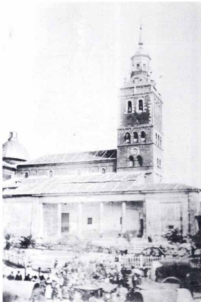
Imagen de la Iglesia de San Miguel en la que se puede ver la torre antes del incendio que sufrió en el año 1903.
