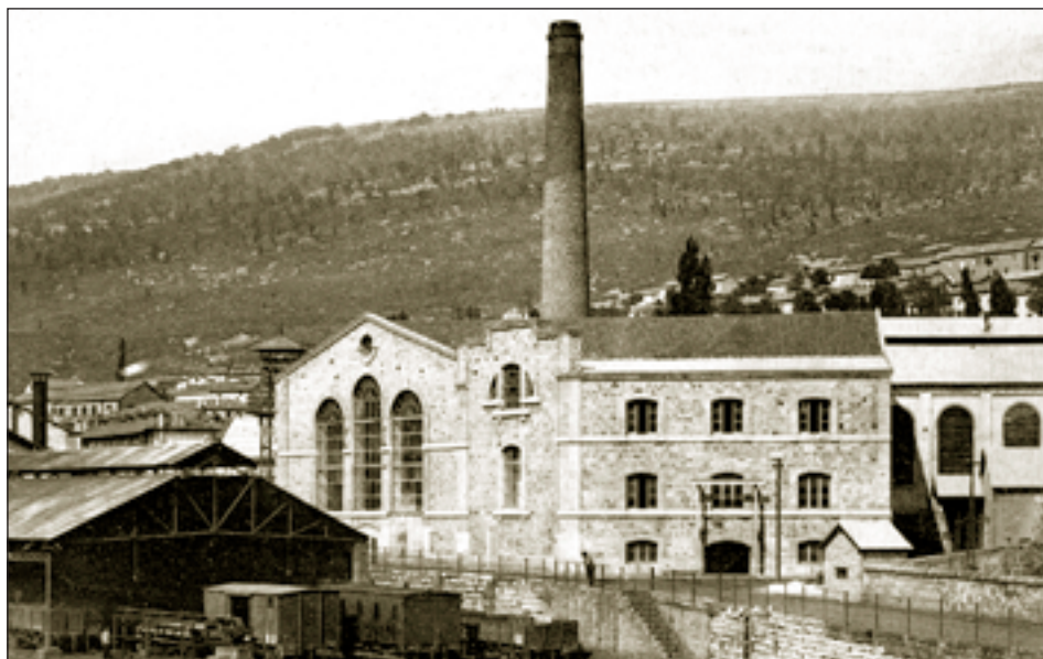
La nueva central eléctrica de las minas de Barruelo se acabó de construir a principio de los años veinte. Aunque poco después la empresa Viesgo se encargó de proporcionar el suministro, la central permaneció activa para casos de emergencia.
