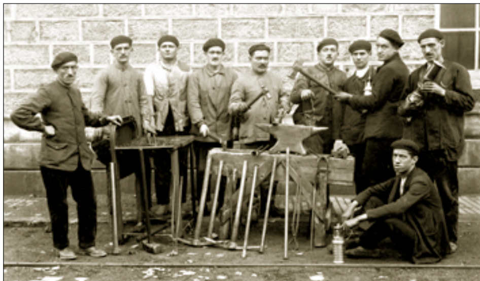
Miles de obreros han trabajado a lo largo de los años en el Calero. La imagen reproduce a un grupo de herreros fotografiados junto a las instalaciones del emblemático pozo.
