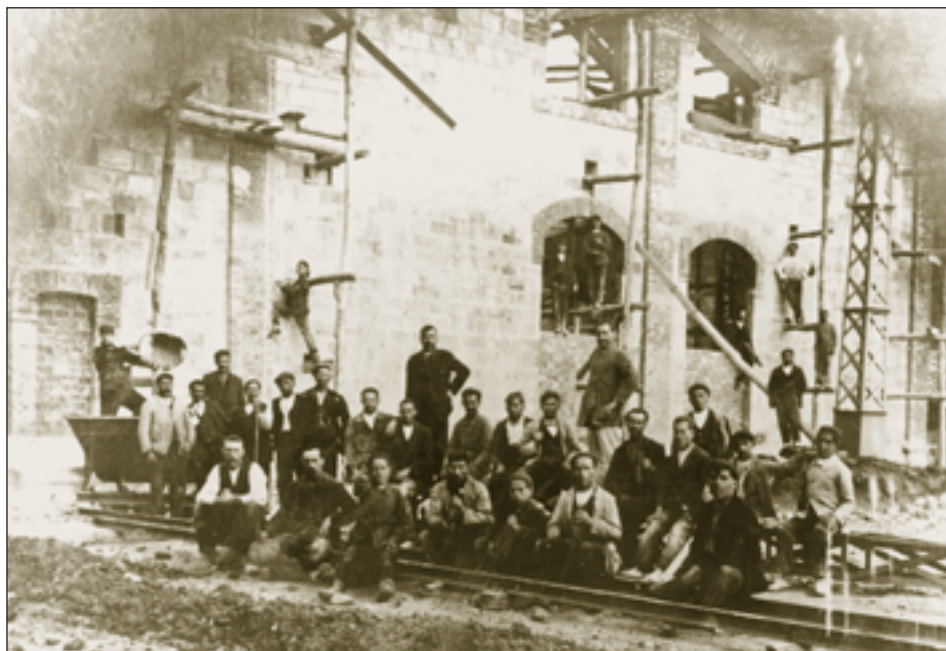
Trabajadores levantando el edificio de la sala de máquinas del grupo inferior Calero, en torno a 1912.
