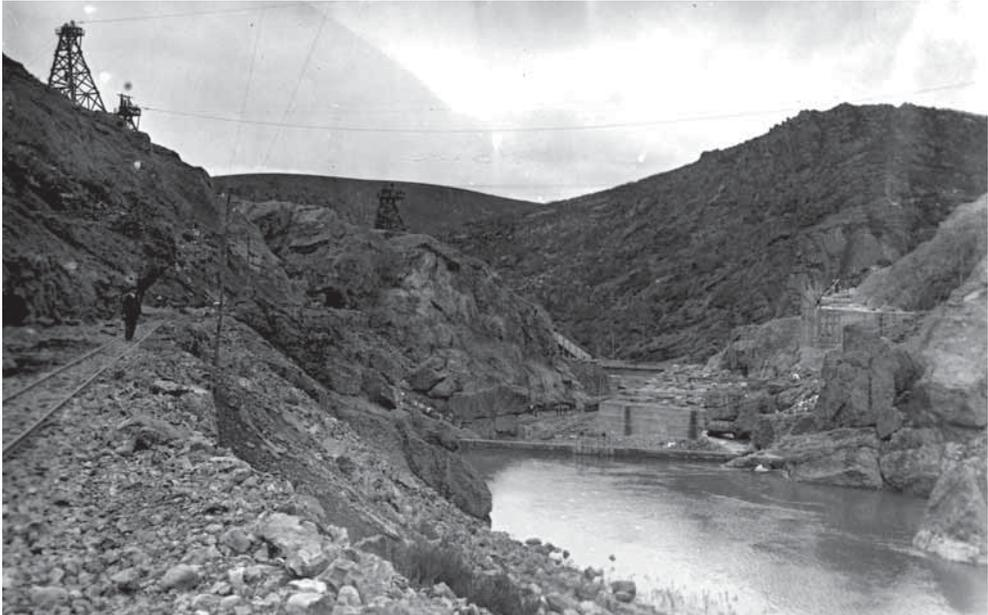
*Construcción del pantano de La Requejada, en los años veinte. A la izquierda pueden verse los ralles del ferrocarril de cantera instalado para el traslado de los materiales de construcción. Imagen: Archivo Histórico Provincial de Palencia.*
